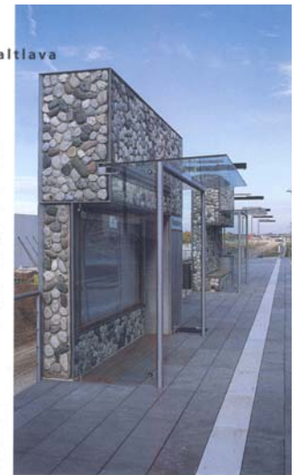
Kiesel grober Körnung unterschiedlicher Herkunft, Farbe, Form und Struktur als Warteblockbehangmaterial. Ein Korsett aus Flachstählen bildet den dreidimensionalen bauseitigen Rahmen, der mit den Fertigteilen ausgefacht wird.
