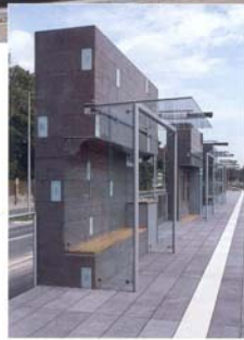
Gesamtansicht der Haltestellenblöcke aus MENDINGER BASALTlava.
